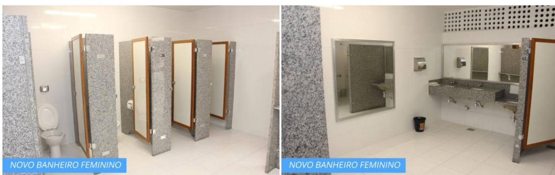
Figura 15 – Reforma dos banheiros
